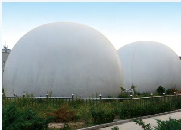
生产基地中药渣综合利用项目
