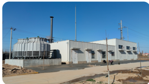
污水站沼气发电项目
